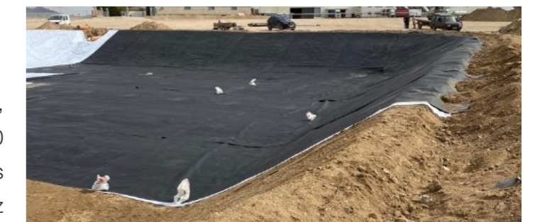
Construcción de balsa de recogida de aguas pluviales en nuestras instalaciones.
